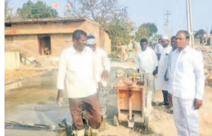
గజ్వేల్ ఎస్. కాలనీలో సీసీరోడ్డు పనులను పరిశీలిస్తున్న మున్సిపల్ చైర్మన్ ఎస్. రాజమౌళి
