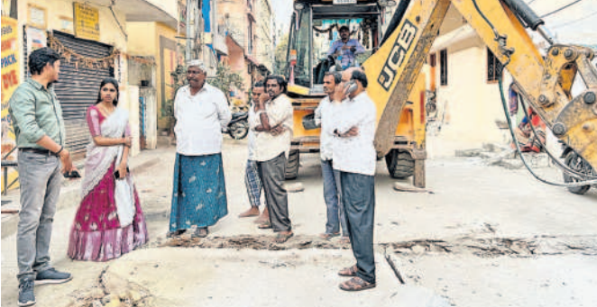
సీసీ రోడ్డు నిర్మాణ పనులను పరిశీలిస్తున్న స్థానిక కార్పొరేటర్ హేమ
