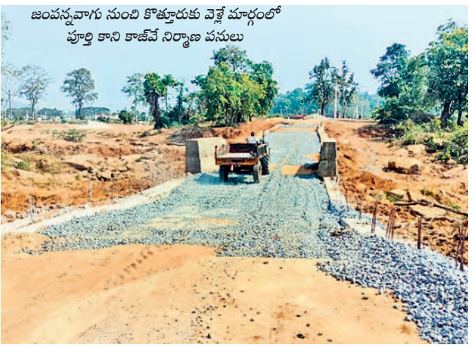
జంపన్నవారి నుంచి కొత్తూరుకు వెళ్లే మార్గంలో పూర్తి కాని కాజీవే నిర్మాణ పనులు
