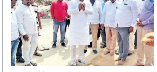
సీన్ రోడ్డు పనులను ప్రారంభిస్తున్న దాతలు
