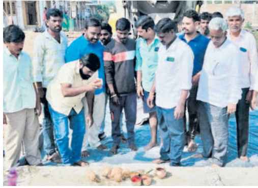
బోర్డం క్యాంపులోని దుర్గమ్మ కాలనీలో సీసీ రోడ్డు పనులను ప్రారంభిస్తున్న గ్రామస్థులు
