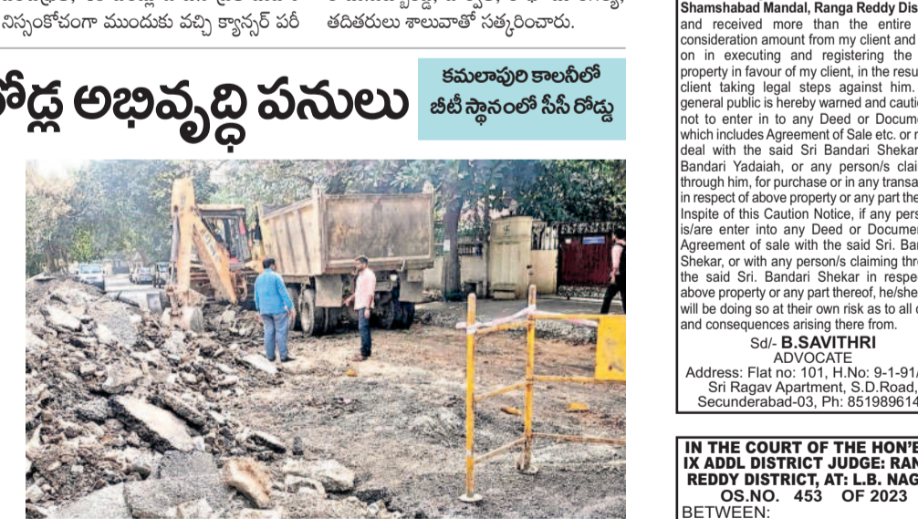
కమలాపురి కాలనీలో తీవ్ర రోడ్డు తొలగింపు పనులు చేపడుతున్న జీహెచ్ఎంసీ నిర్మాణ
