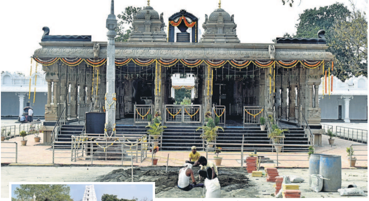
నాగోబా ఆలయంలో పర్శిలను ఏర్పాటు చేస్తున్న కార్మికులు
