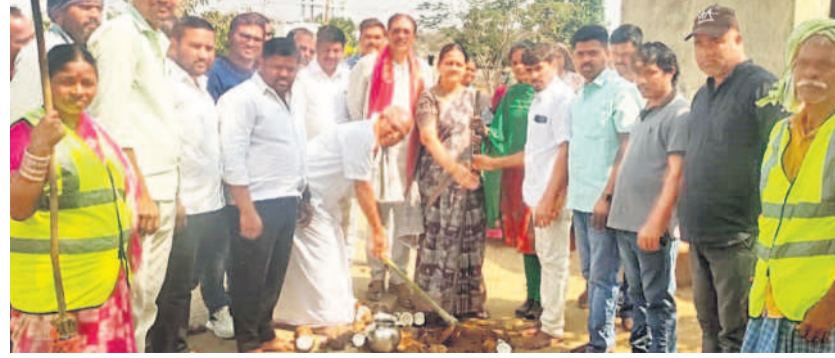
వల్లెచెల్లెండంలో అండరగ్రౌండ్ డ్రైవ్ నే నిర్మాణ పనులను ప్రారంభిస్తున్న ఎంపీటీ కట్టెమోత్యానాయక్
