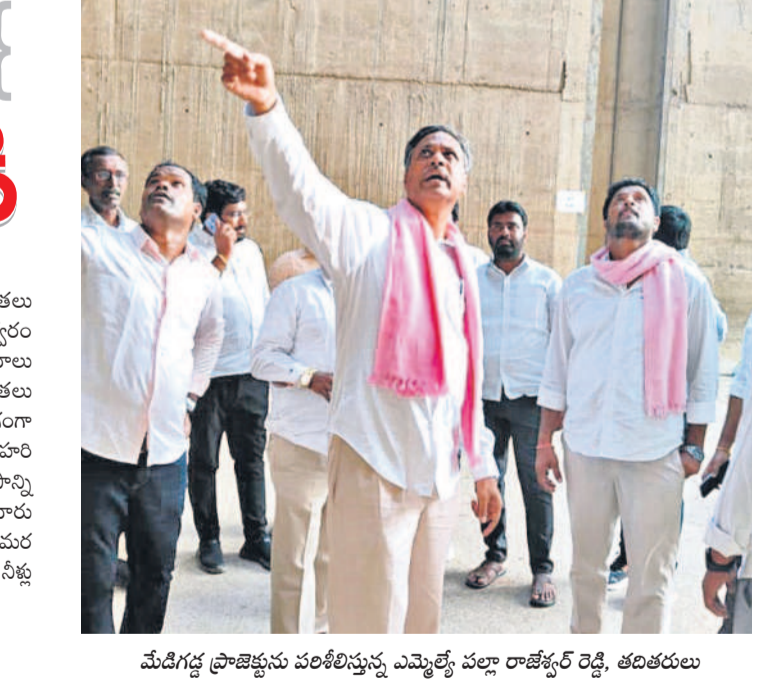
మేడిగడ్డ ప్రాజెక్టును పరిశీలిస్తున్న ఎమ్మెల్యే వల్ల రాజేశ్వర్ రెడ్డి, తదితరులు
