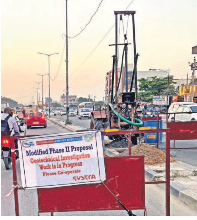
మియాపూర్-చటాన్చెరూ మార్గంలో కొనసాగుతున్న మెట్రో పనులు
