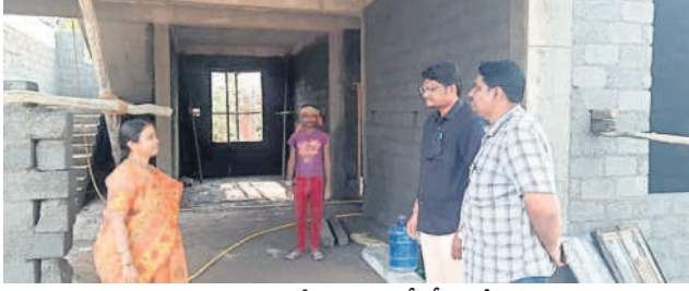
నిర్మాణ పనులను పరిశీలిస్తున్న జడ్పీ సీకెవో ఉమారాజ్
