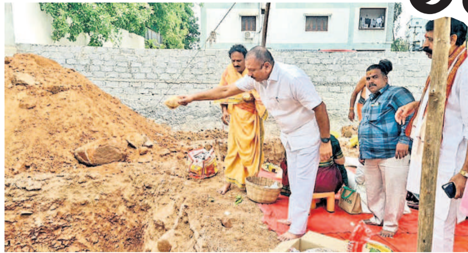
బాలాజీనగర్ కాలనీలో నూతనంగా నిర్మిస్తున్న శివ ఆంజనేయస్వామి సహిత రామాలయం నిర్మాణానికి భూమి పూజ చేస్తున్న ఎమ్మెల్యే దేవిరెడ్డి సుధీర్రెడ్డి
