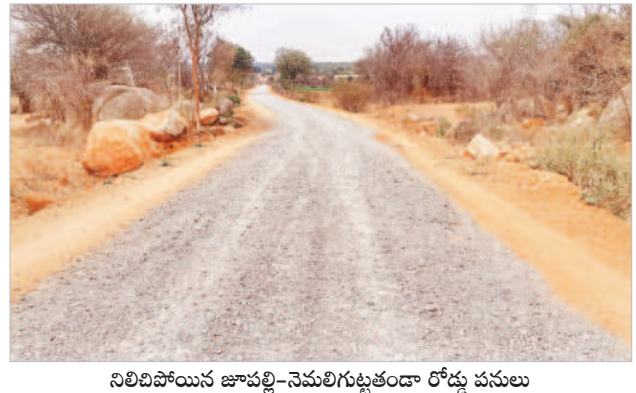
నిలిపివేయిన జూపల్లి-నెమలిగుట్టలకు రోడ్డు పనులు
