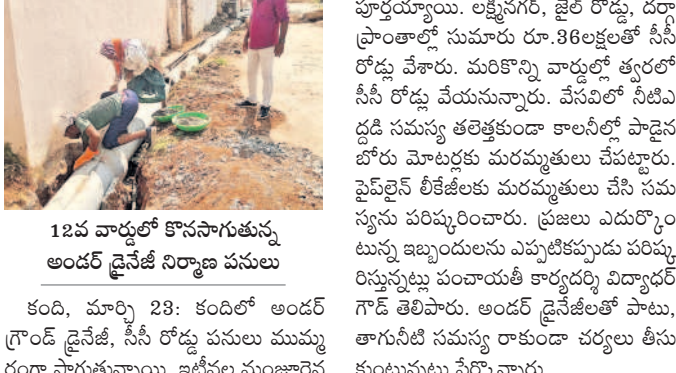
12 వార్డులలో కొనసాగుతున్న అండర్ డ్రైనేజీ నిర్మాణ పనులు
