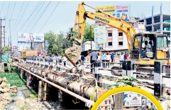
నయానగర్ బ్రిడ్జి కూల్చివేత పనులను పర్యవేక్షిస్తున్న ఎమ్మెల్యే నాయని రాజేందర్ రెడ్డి
