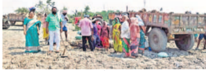
ఉపాధి హామీ పనుల పరిశీలన
