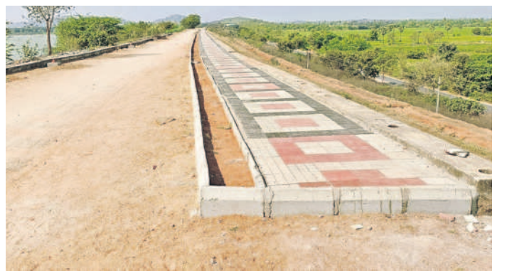
మధ్యలోనే ఆగిపోయిన ఎల్లమ్మ చెరువు కట్టపై వాకింగ్ ట్రాక్ పనులు
