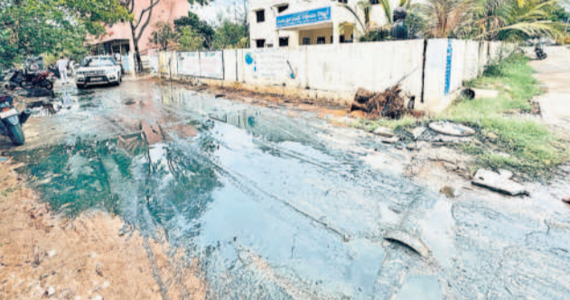
మండల పరిషత్ కార్యాలయం వద్ద రోడ్డుపై పారుతున్న జైనేజీ నీరు
