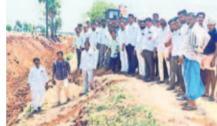
శాలిగారం: తొమ్మిదవ రోజు కాల్వ పనులను పరిశీలిస్తున్న నాయకులు
