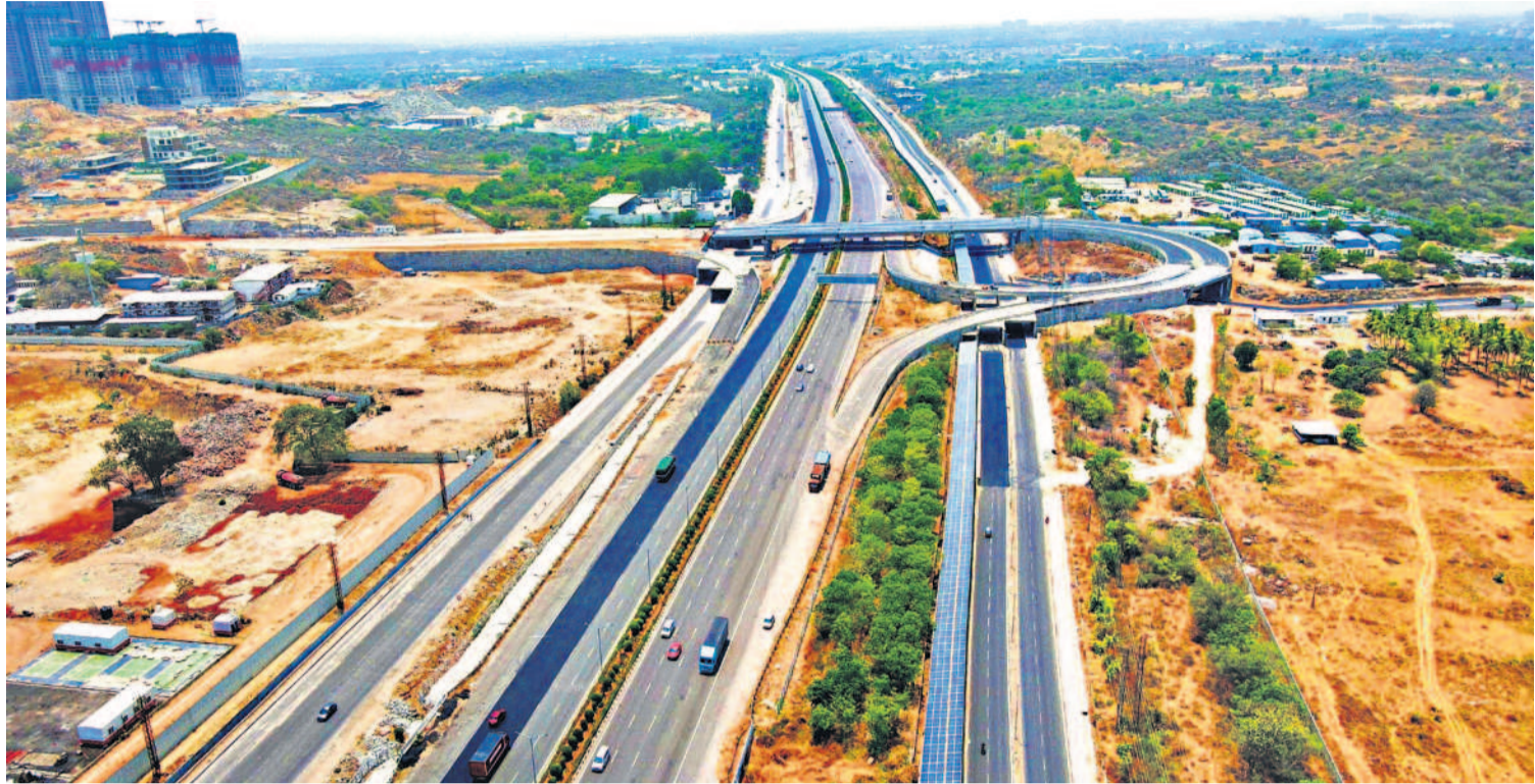
బెటర్ రింగ్ రోడ్డుపై కోకాపేట నియో పాలీస్ లేఅవుట్ ను కలుపుతూ హెచ్ఎండిపి నిర్మిస్తున్న ట్రంపెట్ నిర్మాణం
