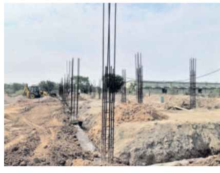
ప్రారంభమైన భవన నిర్మాణ పనులు
