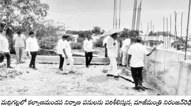
మద్దిగట్లలో కల్యాణమండప నిర్మాణ పనులను పరిశీలిస్తున్న మాజీమంత్రి నిరంజన్ రెడ్డి
