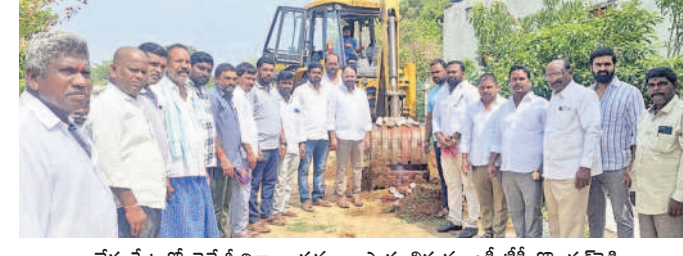
బేగంపేటలో డైనేజీ నిర్మాణ పనులు ప్రారంభిస్తున్న జడ్పీటీసీ కొండలరెడ్డి
