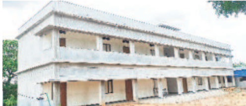
మసాపూర్లో రూ.1.50 కోట్లతో నిర్మించి అసంపూర్ణా వదిలిన భవనం
