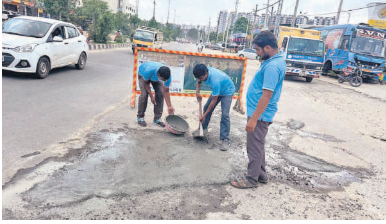
రోడ్డు గుంతలను పూడ్చుతున్న మియాపూర్ ట్రాఫిక్ పోలీసులు
