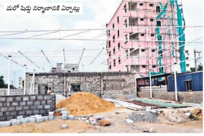
మరో షెడ్ల నిర్మాణానికి ఏర్పాట్లు
