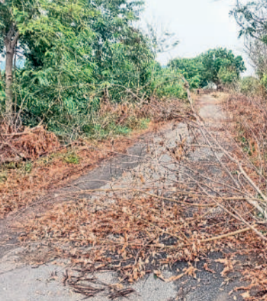
శాయంపేట - కొత్తగూడెం సంగం రోడ్డు పక్కన చెట్లను నరికి వదిలేయడంతో రోడ్డుపై వడిన దృశ్యం
