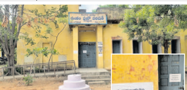
నాగిరెడ్డిపేటలో మండల పరిషత్ కార్యాలయ భవనం, కార్యాలయం వెనుక భవనంలోకి మార్చినట్లు అతికించిన పేపర్
