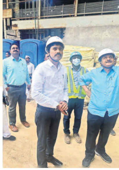
యాదాద్రి పవర్ ప్లాంట్ పనులను పరిశీలిస్తున్న కలెక్టర్ నారాయణరెడ్డి
