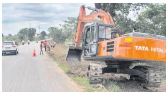
పోచారం వద్ద కొనసాగుతున్న జాతీయ రహదారి పనులు
