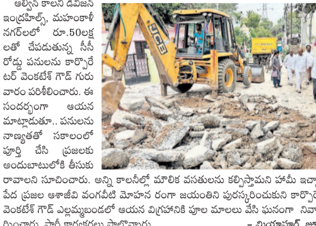
అల్లిగ్ కాలనీ డివిజన్ ఇన్చార్జ్ ముహూర్తా నగర్ లో రూ.50 లక్షలతో చేపడుతున్న సీసీ రోడ్డు పనులను కార్పొరేటర్ వెంకటేశ్ గౌడ్ గురువారం పరిశీలించారు. ఈ సందర్భంగా ఆయన మాట్లాడుతూ.. పనులను నాణ్యతతో సకాలంలో పూర్తి చేసి ప్రజలకు అందుబాటులోకి తీసుకు రావాలని సూచించారు. అన్ని కాలనీలో మౌలిక వసతులను కల్పిస్తామని హామీ ఇచ్చారు. పేద ప్రజల ఆశాజ్యోతిగా మోహన్ రంగా జయంతిని పురస్కరించుకుని కార్పొరేటర్ వెంకటేశ్ గౌడ్ ఎల్లమ్మ బండలో ఆయన విగ్రహానికి పూలమాలలు వేసి ఘనంగా నివాళులర్పించారు. పార్టీ కార్యకర్తలు పాల్గొన్నారు. - మియాపూర్, జూలై 4
