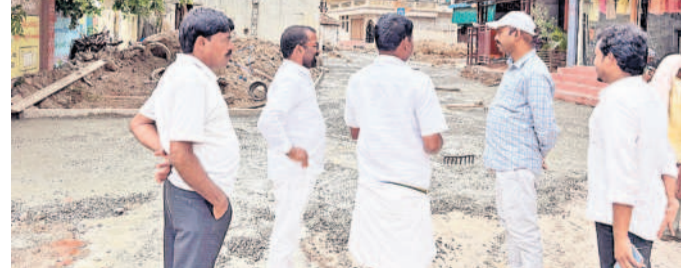
సీసీ రోడ్డు పనులపై ఇంజనీరింగ్ అధికారులతో మాట్లాడుతున్న కౌన్సిలర్ శంపాబాద్ రాజు
