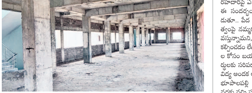
రెండో ఫ్లోర్లో అసంపూర్ణంగా ఉన్న నిర్మాణ పనులు
