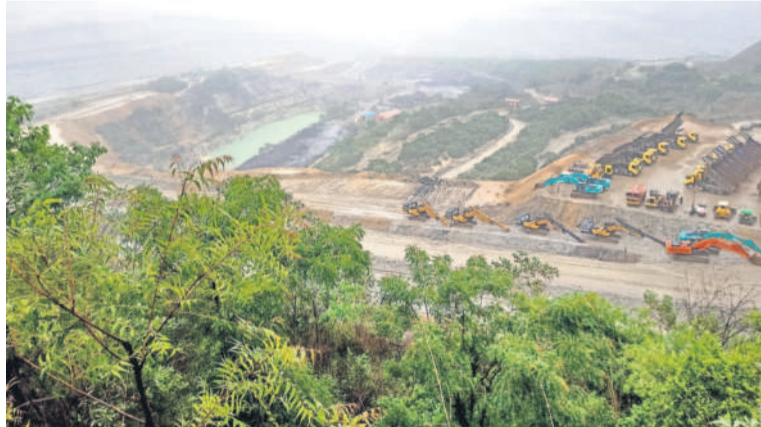
శ్రీరాంపూర్ : భారీ వర్షాలతో నిర్మాణాధిభంగా మారిన ఓసీపీ క్వారీ
