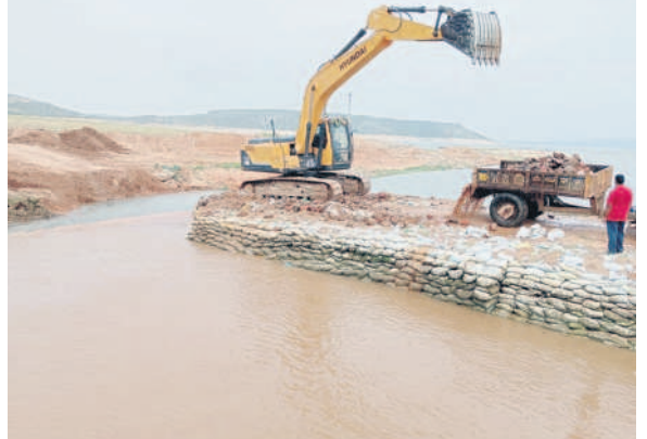
పుట్టంగండి జిల్లా పాయింట్ వద్ద అప్రోచ్ కెనాల్ అడ్డుకట్ట తొలగింపు పనులు
