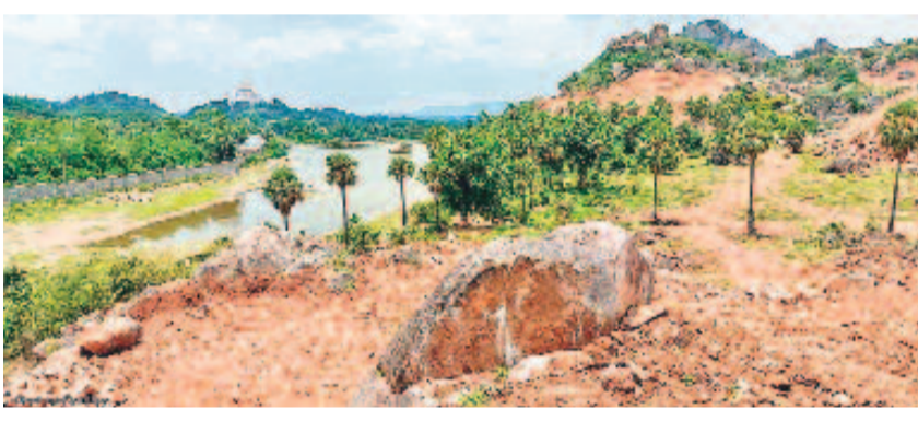
ఇందిరాసాగర్ చెరువు వద్ద ముమ్మరంగా సాగుతున్న పనులు
