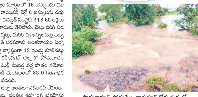
సారంగాపూర్: పోవంపేట-నాగునూర్ రోడ్డు మధ్యలో కోతకు గురైన రూదాల
