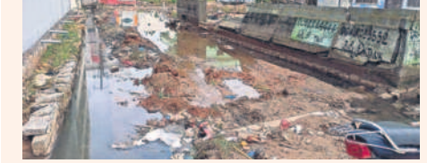
మరదలుతులకు గురైన రోడ్డు పక్కనే వరద ప్రవాహానికి దెబ్బతిన్న గోడ
