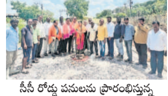
సీసీ రోడ్డు పనులను ప్రారంభిస్తున్న కార్యారంభించారు పుష్పానగేశి
