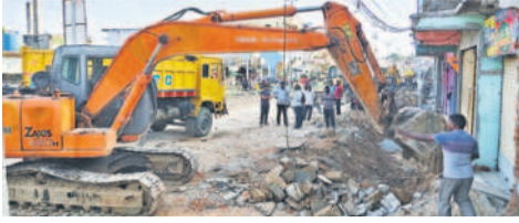
మోతూరు: డ్రైనేజీ నిర్మాణంలో మట్టి పనులను పరిశీలిస్తున్న మున్సిపల్ కమిషనర్ శ్రీకాంత్
