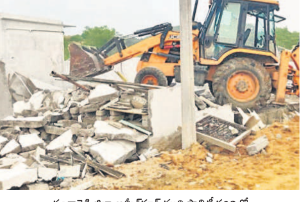
సంగారెడ్డి జిల్లా అమీన్పూర్ మున్సిపాలిటీ వద్ద అక్రమ నిర్మాణాలను కూల్చివేస్తున్న అధికారులు
