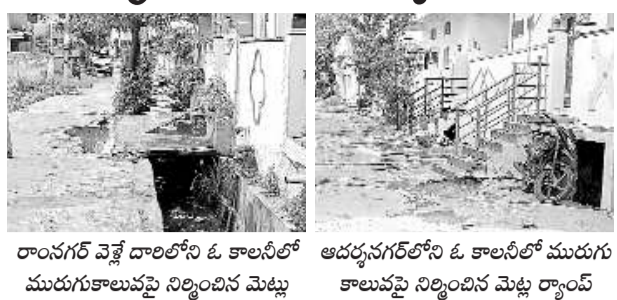
రాంనగర్ వెళ్ల దారిలోని ఓ కాలనీలో ఆదర్శనగర్లోని ఓ కాలనీలో మురుగు మురుగుకాలువపై నిర్మాణం మొదలుపెట్టారు.
