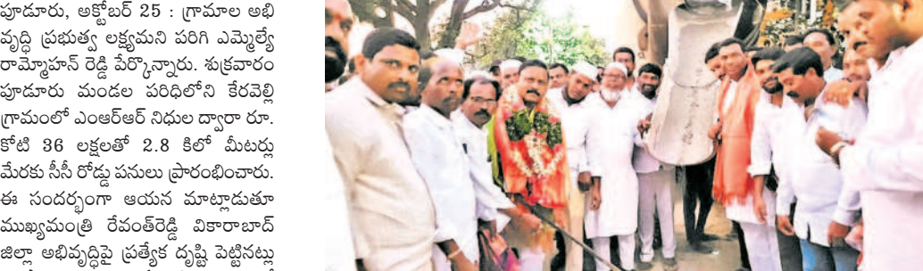
సీసీ రోడ్డు నిర్మాణ పనులు ప్రారంభిస్తున్న ఎమ్మెల్యే రామోహన్ రెడ్డి
