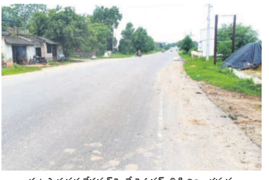
పుట్టపాక వద్ద నేషనల్ హైవే షిఫ్ట్ లో నిర్మాణ పనులు మండల-విభజన రహదారి
