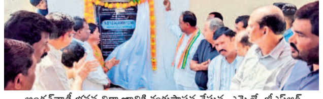
అంగన్వాడీ భవన నిర్మాణానికి శంకుస్థాపన చేస్తున్న ఎమ్మెల్యే జీవీఎన్ఆర్
