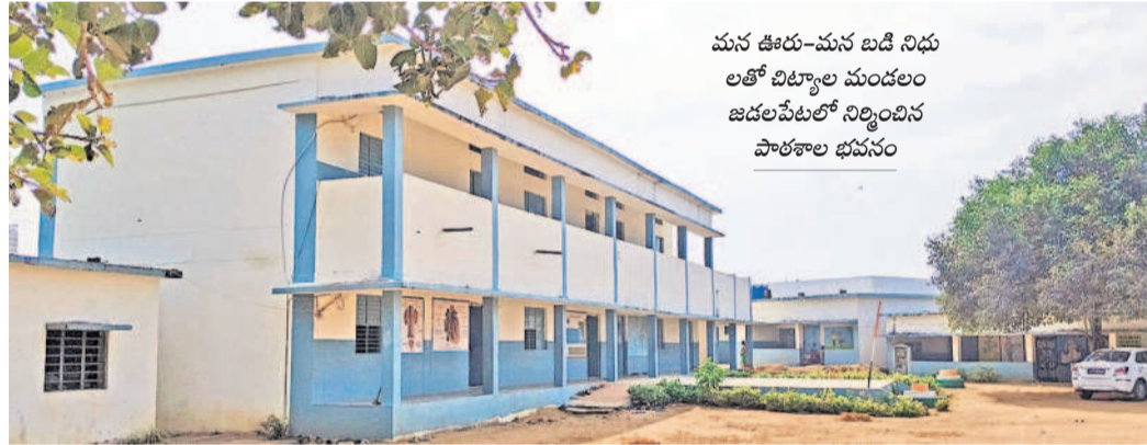
మన ఊరు-మన బడి నిధి లతో బిట్టాల మండలం జడలపేటలో నిర్మించిన పాఠశాల భవనం
