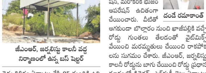
జీఎంఆర్, జర్నలిస్టు కాలనీ వద్ద నిర్మాణంలో ఉన్న బస్ షెల్టర్
