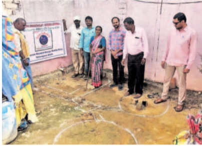
యాచారం: నజ్జీకినిగారంలో మరుగుదొడ్డి నిర్మాణ పనులను పరిశీలిస్తున్న ఎంపీడివో సరేందర్ రెడ్డి
