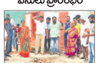
సీసీ రోడ్డు నిర్మాణ పనులు ప్రారంభిస్తున్న చైర్మన్ సీసీ
