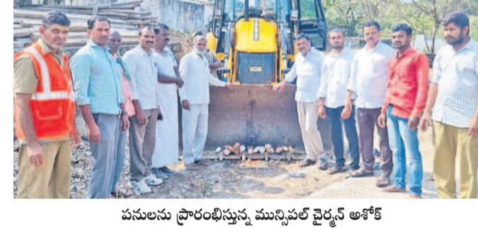
పనులను ప్రారంభిస్తున్న మున్సిపల్ చైర్మన్ అశోక్
